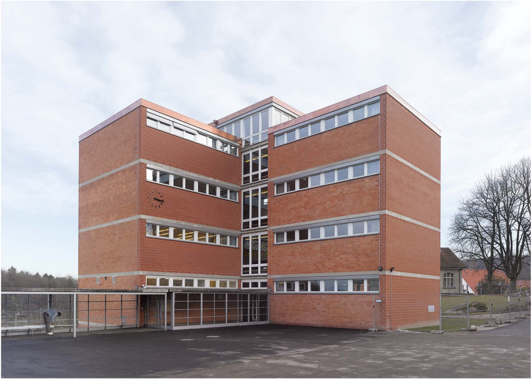
Die neu aufgemauerten Westfassaden (nach rechts blickend) sind homogener und etwas dunkler als die Originalfassaden.
